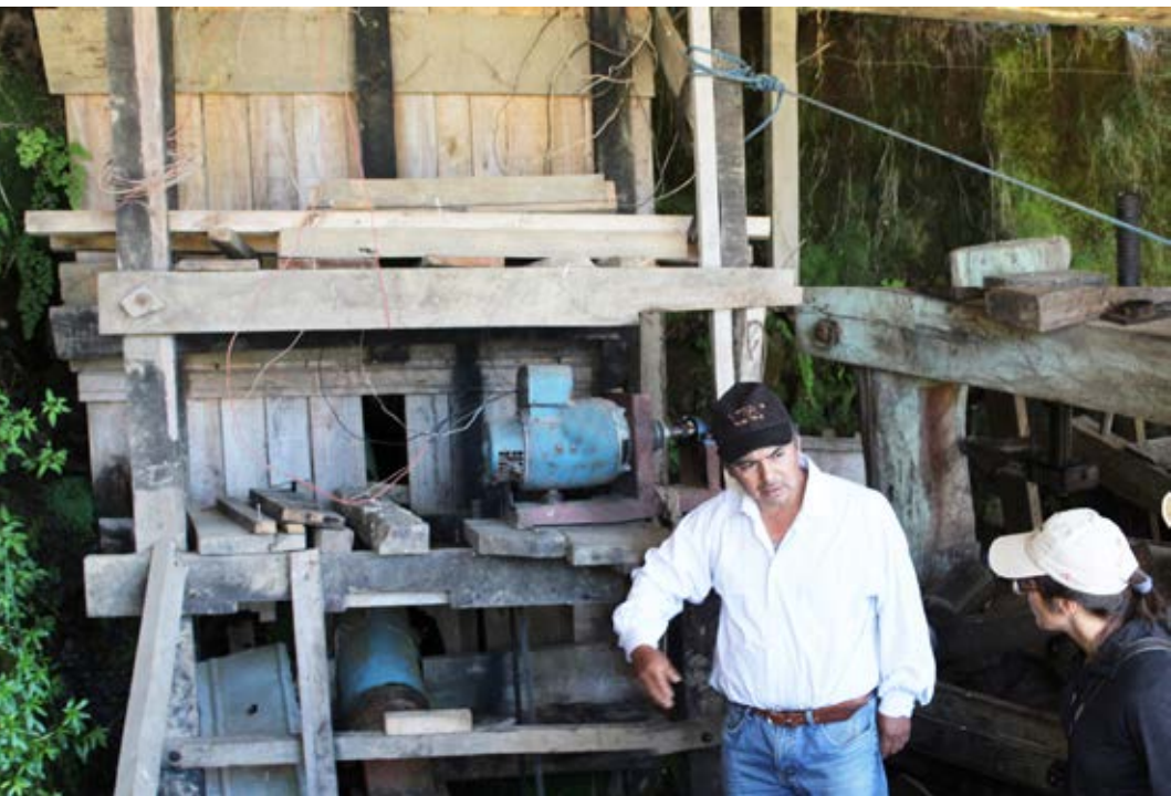
Cirilo Ancalef explicando el funcionamiento de un sistema hidroeléctrico creado por él.
